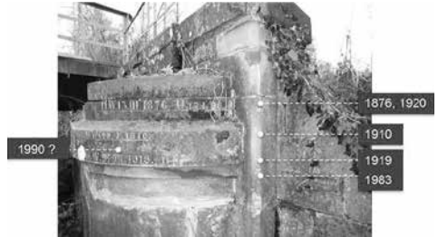
Repères de crue sur la Thur au sud de Colmar D.R.
