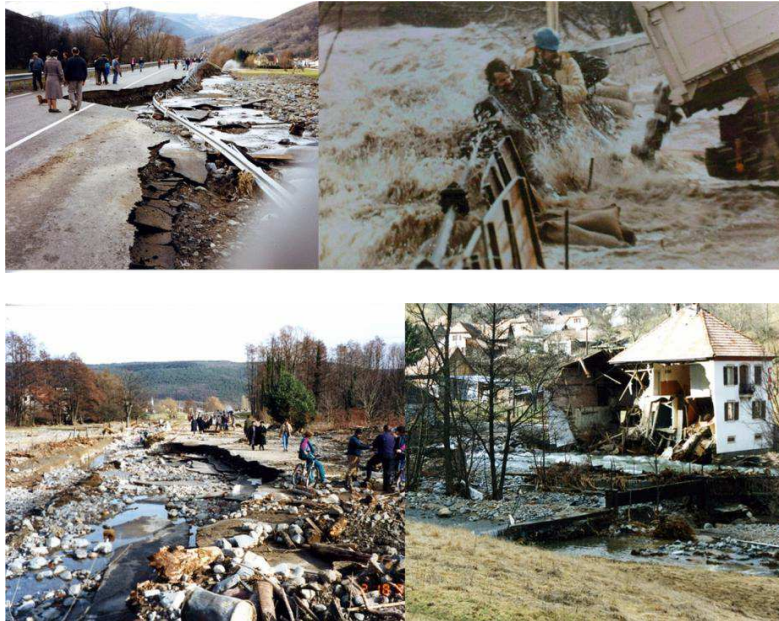
les dégâts des inondations de 1990 dans la vallée de la Lauch
